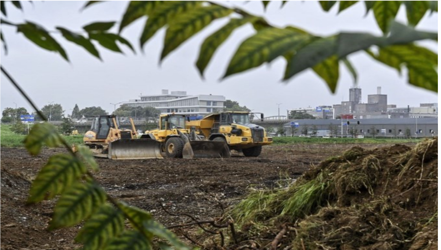
De bulldozers zijn op het Tregaterrein gearriveerd. Afbeelding: Johannes Timmermans
