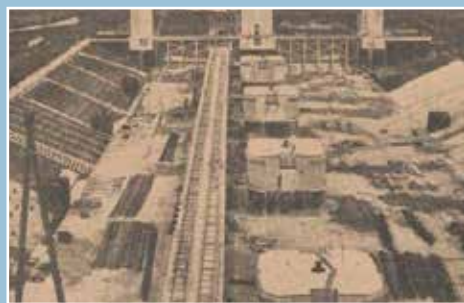
› Aanleg sluiscomplex te Limmel. (Bron: Algemeen handelsblad 25-08-1933)
