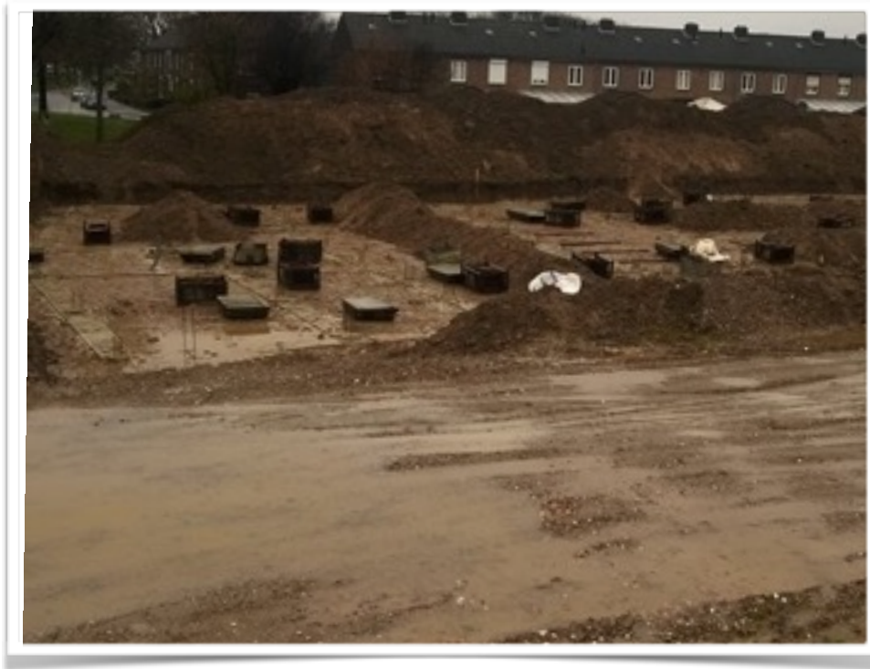
Foto: 1 december 2015 de bouwplaats
